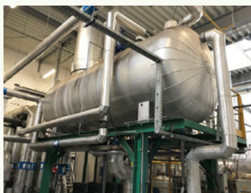
脱気装置設置による改善
